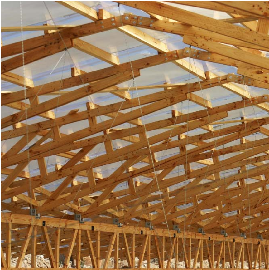
← Spațiu acoperit, vedere de interior cu sistemul de ferme de lemn și acoperire din policarbonat. Roof, inside view with the wooden trusses system and polycarbonate cladding.
