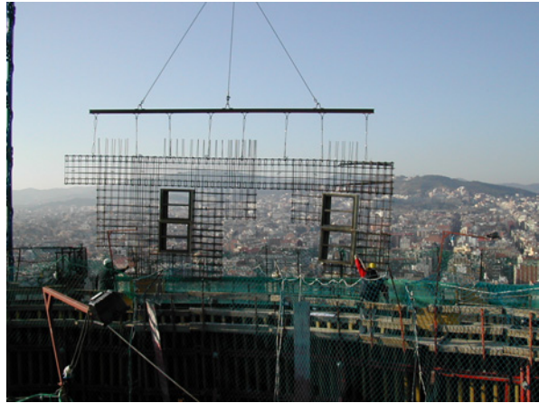
Jaula a punto de entrar en el encofrado
