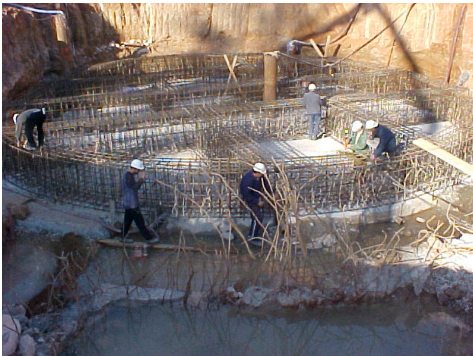
Trabajos en las vigas de coronación de la cimentación del núcleo.
