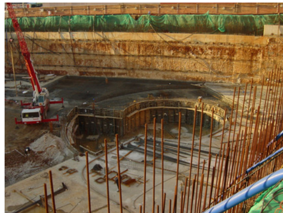
Ejecución de la losa de subpresión.
