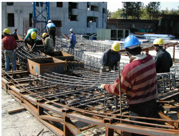
Trabajos de preparación de una jaula en el taller de ferralla a pie de obra.
