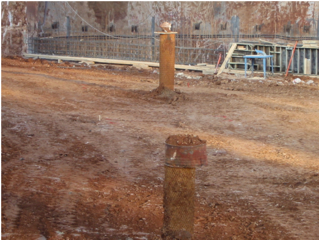
Pozos de obra ya fuera de servicio.
