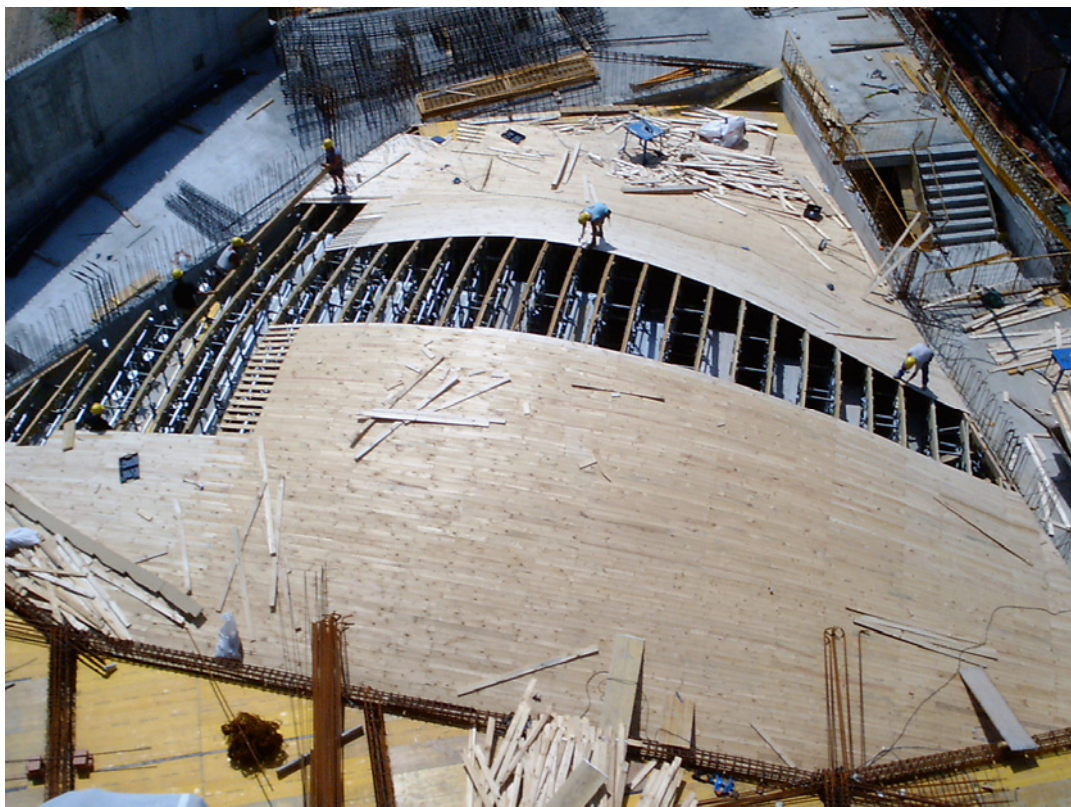
Diferentes momentos de la construcción de la cúpula del Auditorio.
