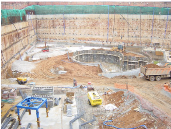
Ejecución de la losa de subpresión.
