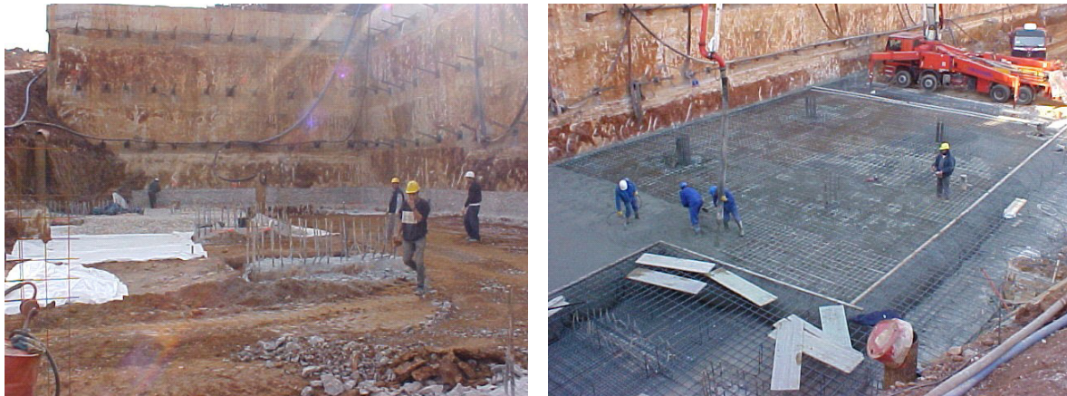
Detalles de la coronación de los bataches en preparación para recibir la losa de subpresión.
