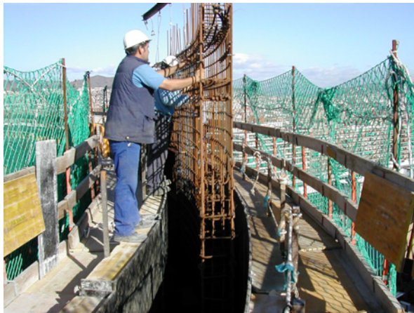
Jaula entrando en el encofrado
