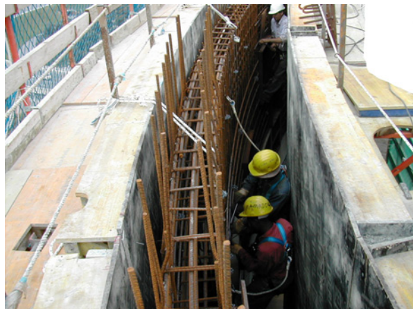
Trabajos en una jaula ya colocada.
