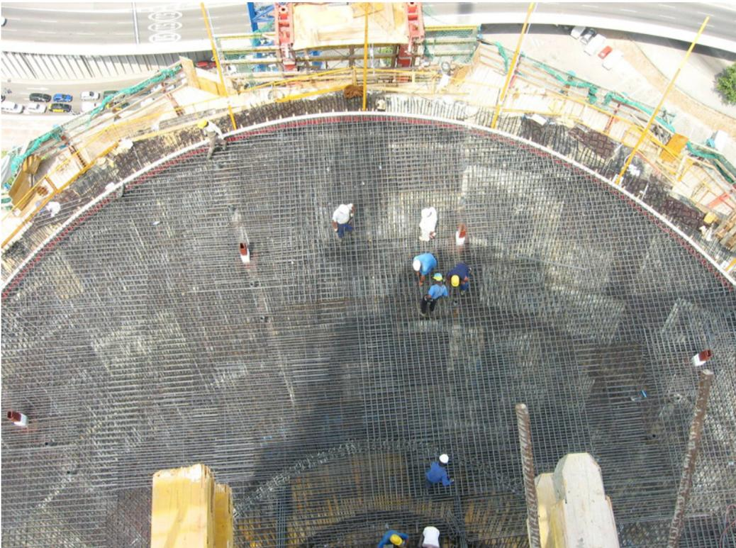
*Colocación de la armadura activa y pasiva en las plantas de Dirección*
