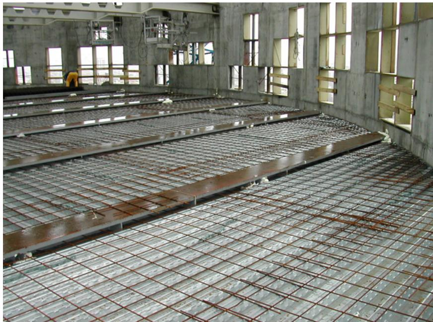
*Sectores de forjado de una Planta Tipo y del techo de una Planta Técnica listos para hormigonar.*
