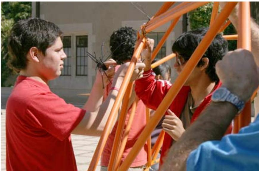
Esta serie de 4 instructivos describe, paso a paso, la construcción y montaje de una estructura liviana (tubos de PVC) con cubierta textil (Tarpaulin), que puede servir de refugio transitorio para personas y enseres, en caso de emergencia. Esta estructura cubre una superficie útil de 20 m<sup>2</sup> aprox. con una altura interior promedio de 2,7 m.
