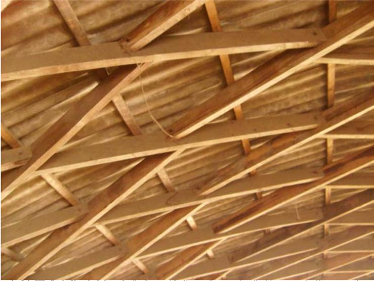
El sistema de malla de madera aserrada funciona a través de vigas de de 2" x 10" que están unidas a 45° entre sí, de manera que una viga se una a la mitad de la siguiente para poder formar la curvatura.
